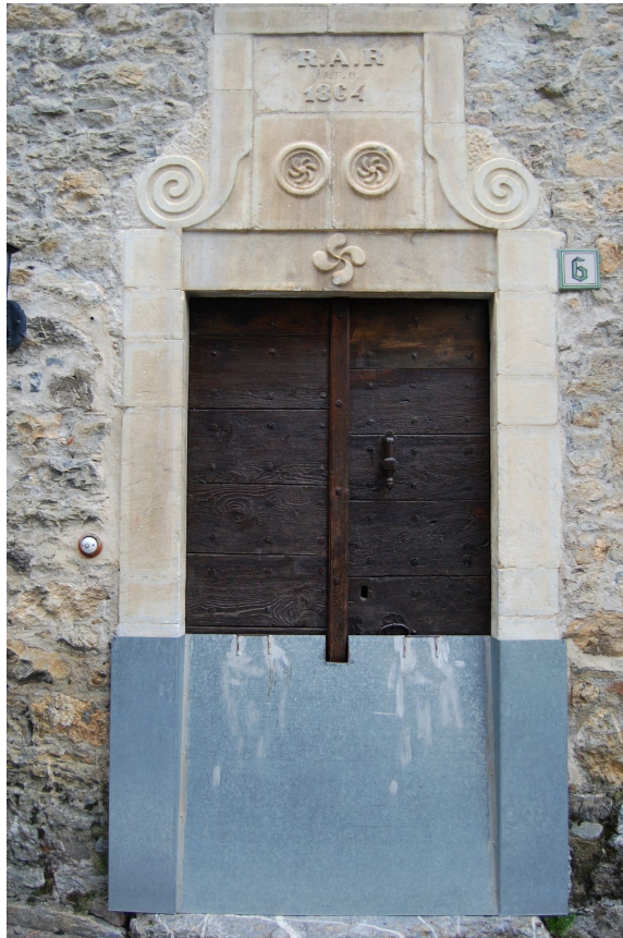
"Cuatrefuellas" en Casa Casalera, Pueyo de Tena, Huesca
